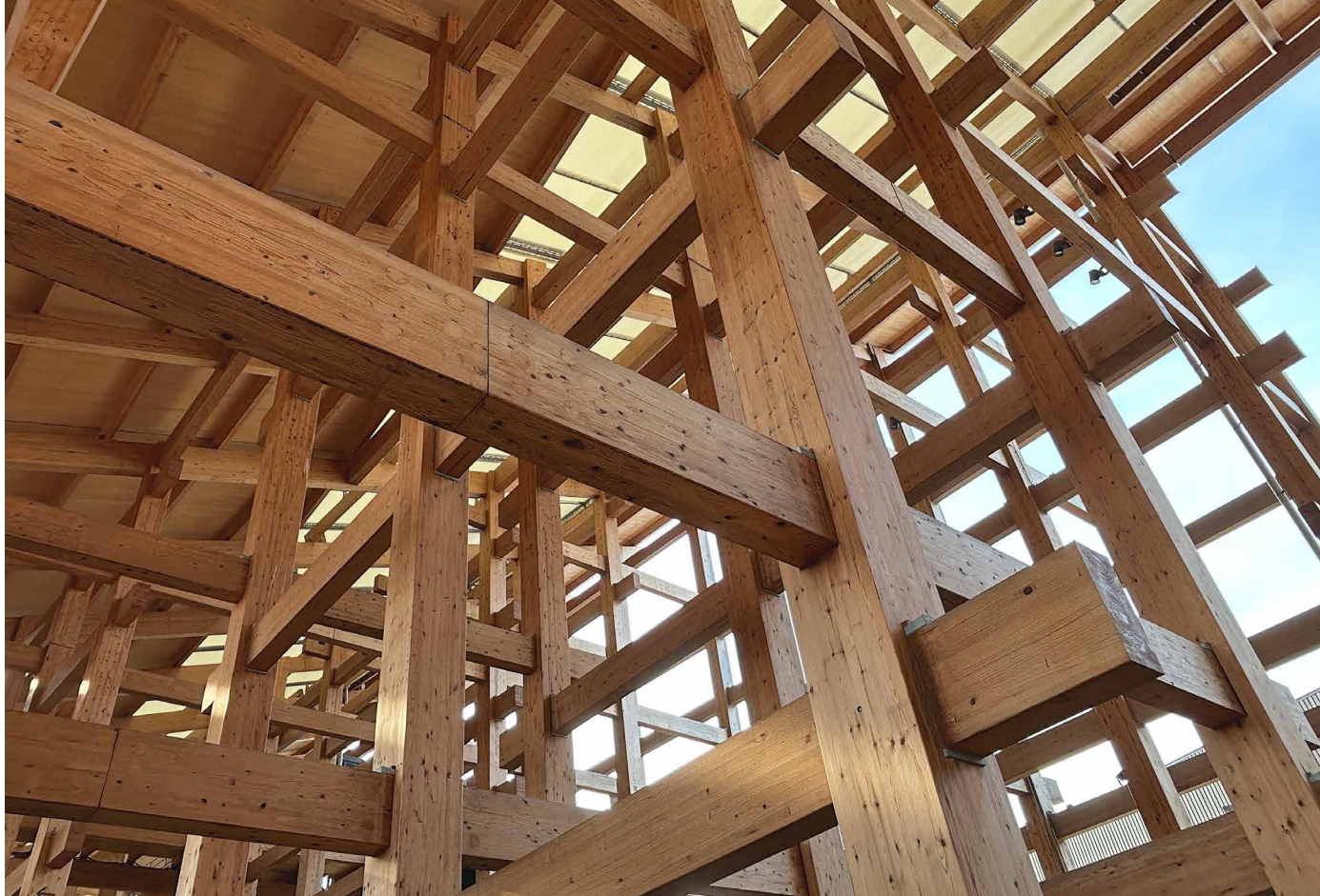
› Detall constructiu del Gran Anell de fusta d'Expo Osaka 2025.
