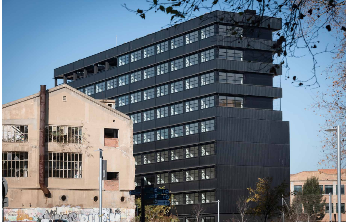
► Marroc 180, al districte 22@ de Barcelona, és un dels projectes referents de Constructora del Cardoner en construcció modular tridimensional. L'edifici es va executar amb mòduls industrialitzats, garantint una alta precisió i un estalvi de temps d'obra, amb acabats d'alta qualitat. Fotografia: ArgotPhoto
