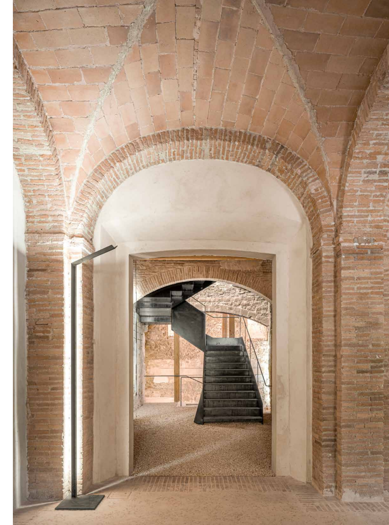
› Paviment de morter de calç, paret d'obra vista i escala de ferro.
