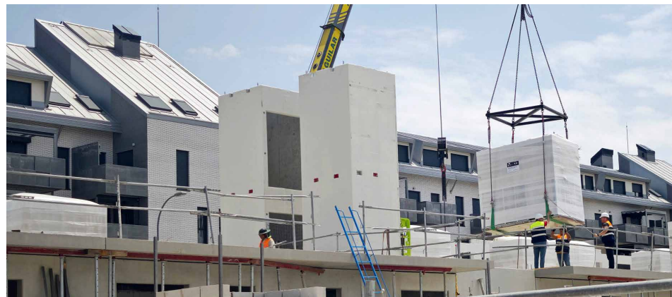
► Pla VIVE III – Velilla. Instal·lació de banys industrialitzats al projecte de 88 habitatges a Velilla de San Antonio (Madrid), dins el Pla VIVE III. La integració d'elements prefabricats, com ara banys i façanes, forma part de l'estratègia de Constructora del Cardoner per optimitzar terminis, recursos i qualitat d'obra. Fotografia: Cardoner Group
