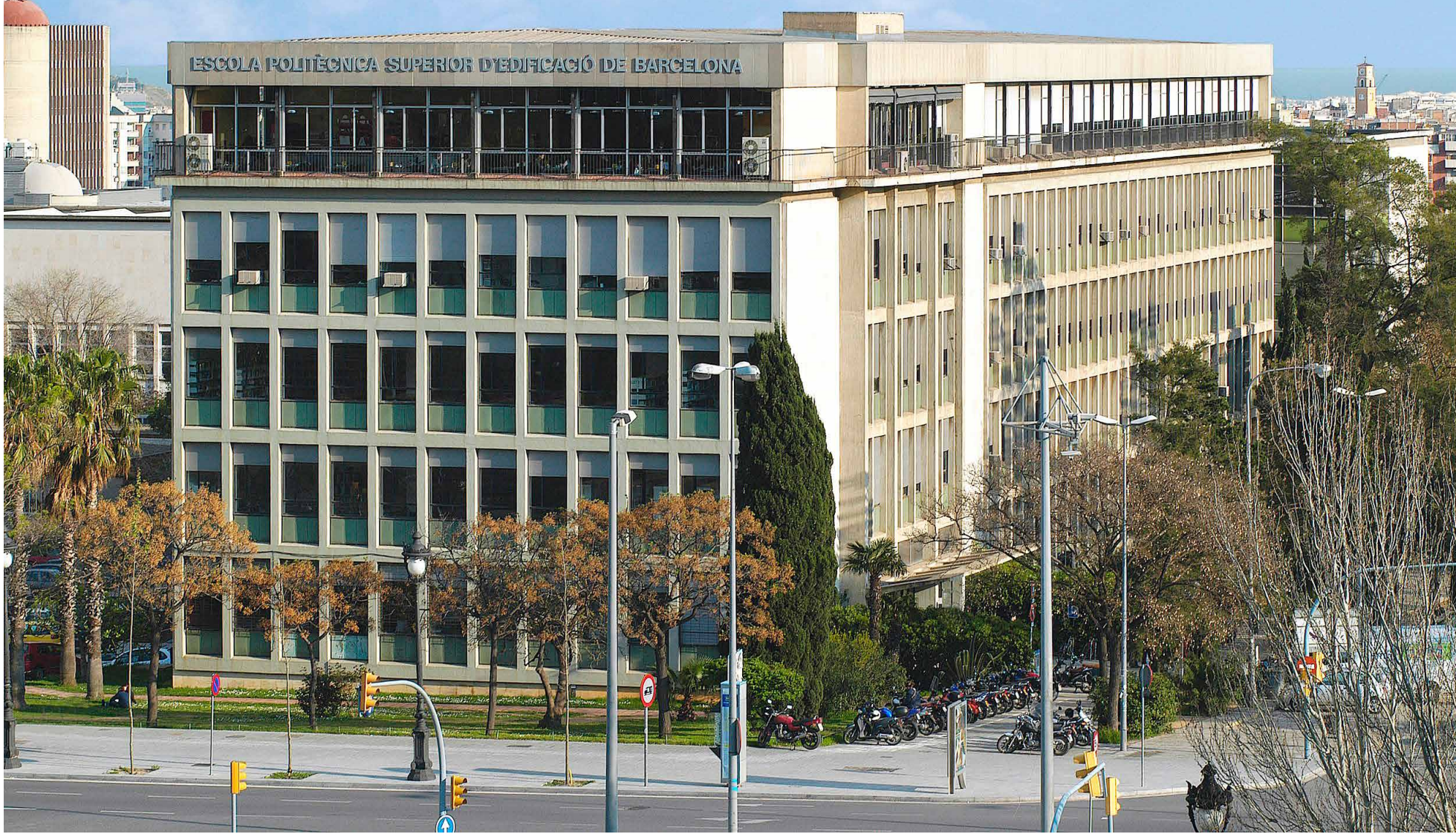
» Façana de l'Escola Politècnica Superior d'Edificació de Barcelona (EPSEB).
