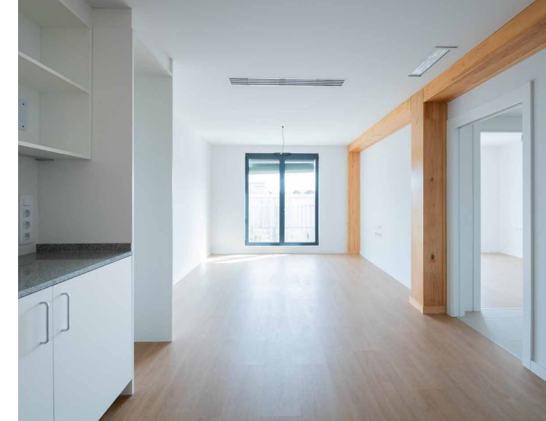
► Casernes J. Interior d'un dels habitatges del projecte Casernes J, al barri de Sant Andreu (Barcelona), executat amb panells de fusta bidimensionals. Una construcció industrialitzada que combina sostenibilitat, eficiència i qualitat d'acabats. Fotografia: ArgotPhoto
