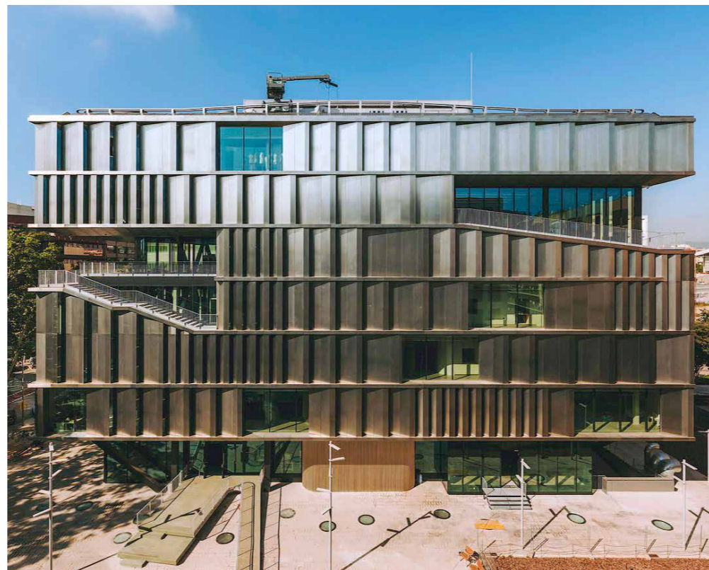
› La façana d'alumini és un dels trets característics de l'edifici.
