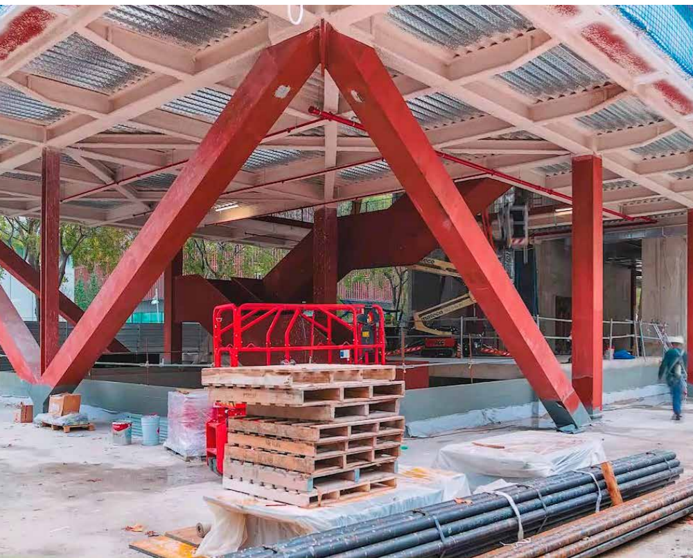
› Estat inicial de l'obra.
