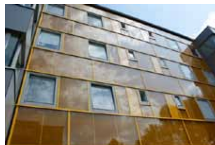
COL·LOCACIÓ MÒDULS PREFABRICATS. ASPECTE FINAL. TOTES LES OBRES EXECUTADES DES DE L'EXTERIOR
