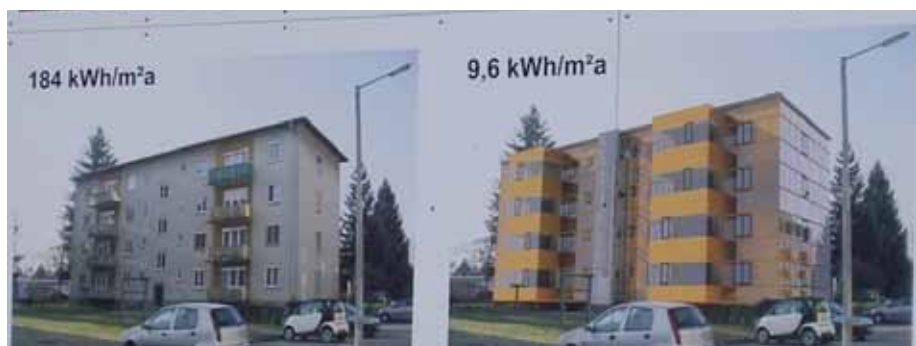
L'EXEMPLE AUSTRIAC ESTÀ SITUAT A DIESELWEG, UN BARRI PERIFÈRIC DE LA CIUTAT DE GRAZ. IMATGE INFORMATIVA DE LA REHABILITACIÓ (FOTO OMR)
