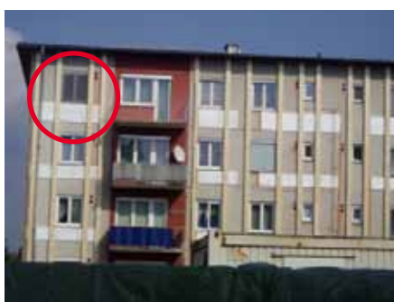
SEQÜÈNCIA DE TREBALLS: COL·LOCACIÓ DE SUBSTRUCTURA I PANELLS RADIANTS (VERMELL), CAMIONS AMB ELS PANELLS A PUNT PER SER COL·LOCATS
