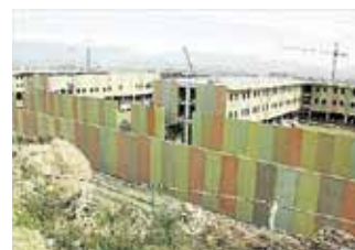
VISTA DEL PROCÉS DE CONSTRUCCIÓ DEL MUR PERIMETRAL DE PUIG DE LES BASSES
