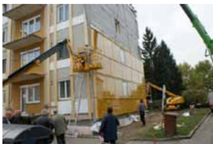
COL·LOCACIÓ MÒDULS PREFABRICATS. ASPECTE FINAL. TOTES LES OBRES EXECUTADES DES DE L'EXTERIOR
