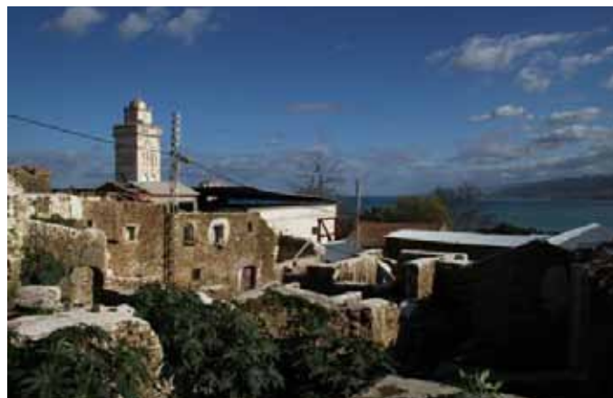
VISTA DEL CENTRE HISTÒRIC DE DELLYS ON PODEM OBSERVAR CASES CAIGUDES A CAUSA DEL TERRATRÈMOL I ELS TREBALLS DE "CONSERVACIÓ PREVENTIVA" DUTS A TERME
