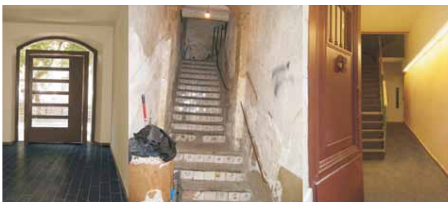
OBRES D'INSTAL·LACIÓ D'ASCENSOR PER A LA MILLORA DE L'ACCESSIBILITAT
